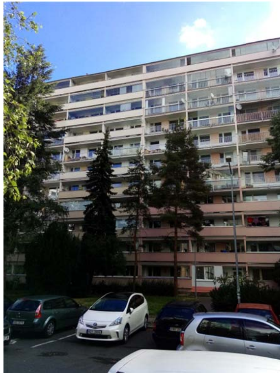
Pohled nad budovu
