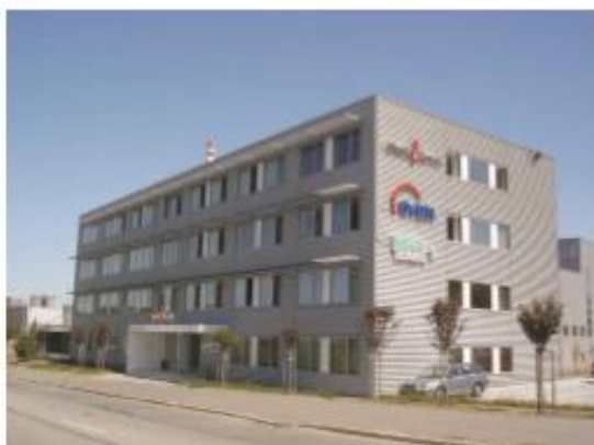
AB Bedimex Praha 10, realizace 2002, výměra 1200 m 2
